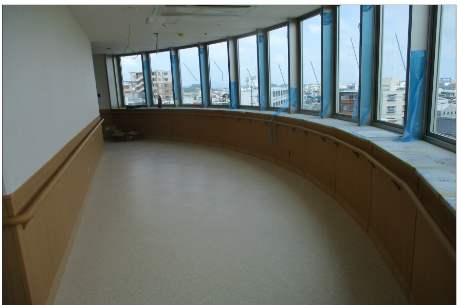
④3～5階病棟 デッキ
